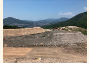
覆土された処分場(写真②)
