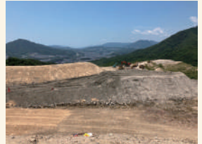
覆土された処分場(写真②)
