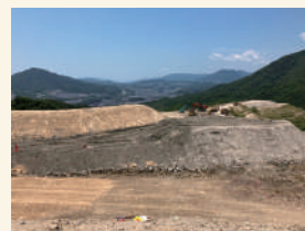
覆土された処分場(写真②)
