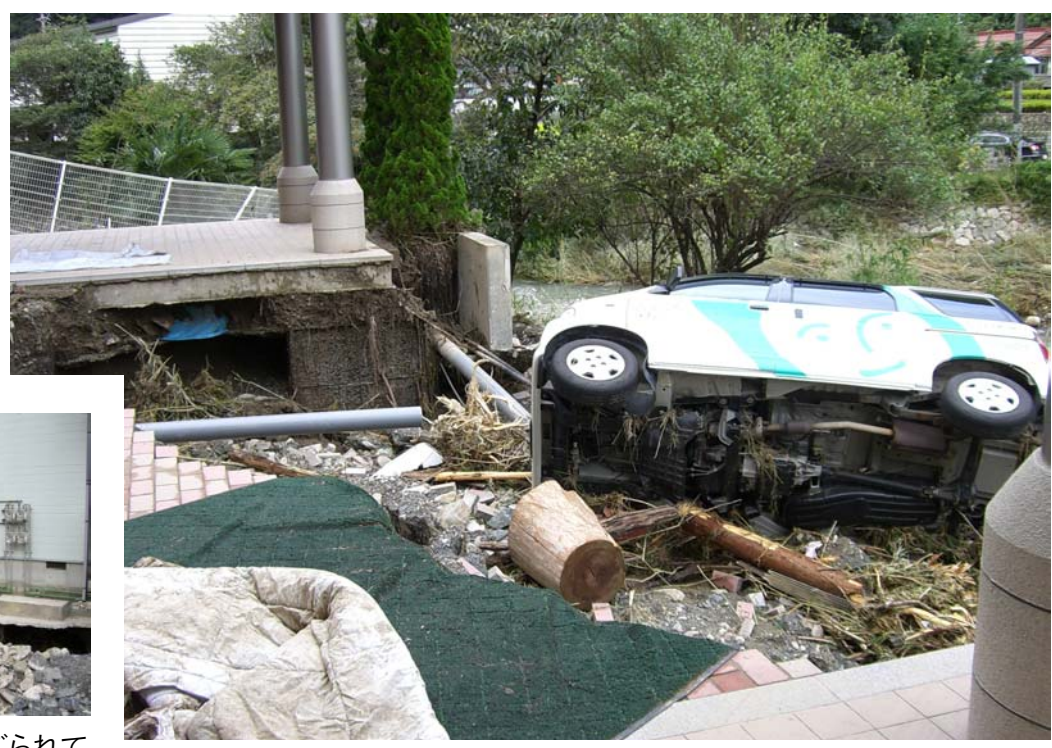
(写真1) 崩壊した老人福祉施設「山まゆ」の玄関前道路(大林町)
