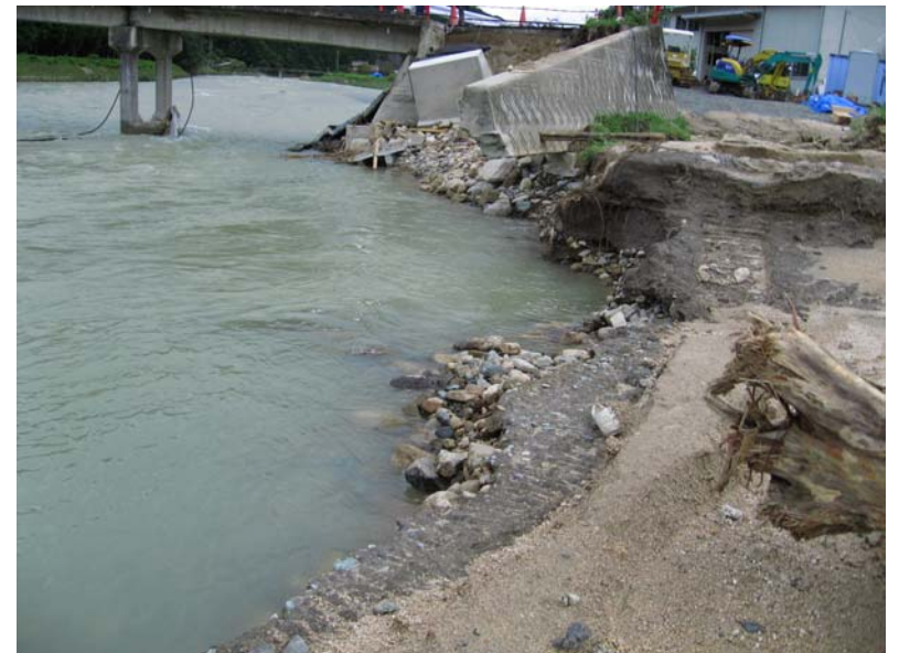
(写真3) 水内川の濁流で崩壊した昨年の台風災害の復旧工事現場(草谷橋左岸)。豪雨時期までの工事期間やぜい弱な工法に批判が出ています。
