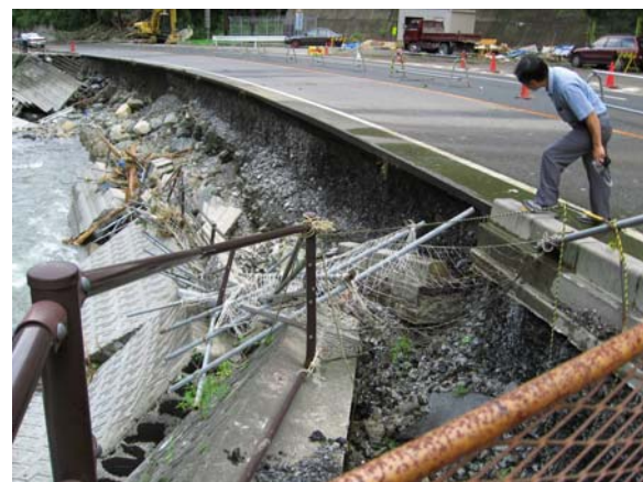
(写真3) 水内川の濁流で崩壊した昨年の台風災害の復旧工事現場(草谷橋左岸)。豪雨時期までの工事期間やぜい弱な工法に批判が出ています。
