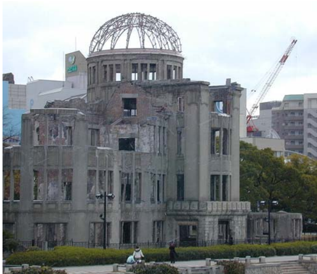
原爆ドームの南東方向わずか100メートルのところでは大型クレーンによるマンション建設が進む＝12月12日、中区・相生橋から撮影
