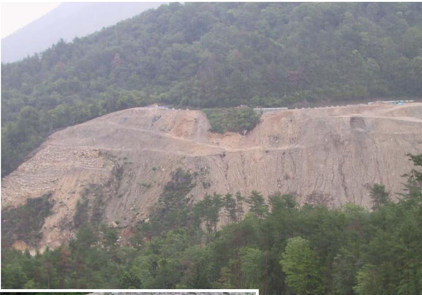
【写真②】写真①の拡大。雨水で崩れ、古タイヤやコンクリート塊も混在している
