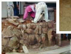
石垣の修復工事
