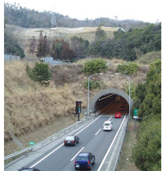
山陽高速道路安芸トンネル下り線入口。上方に土砂埋立現場が見える=4月5日撮影
