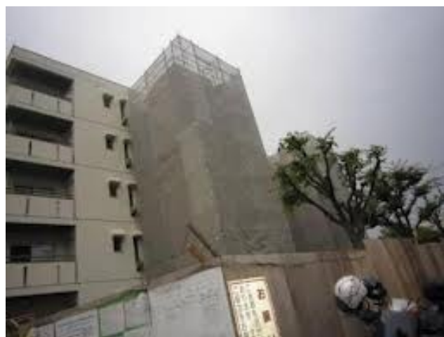
エレベーター設置工事中の江波階段室型市営住宅
