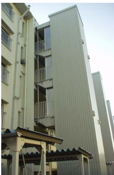
階段室型の公営住宅にエレベーターを設置した静岡市を視察(08年11月)。広島市議会でも取り上げ、ついに今年度予算に設置予算が盛り込まれました。
