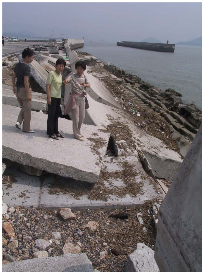
護岸が数十メートルにわたって崩壊した観音マリーナ=9日
