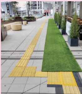
屈曲させられた点字ブロック
